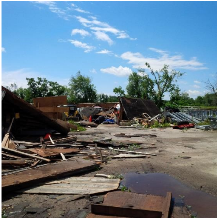
F1 Tornado Damage
