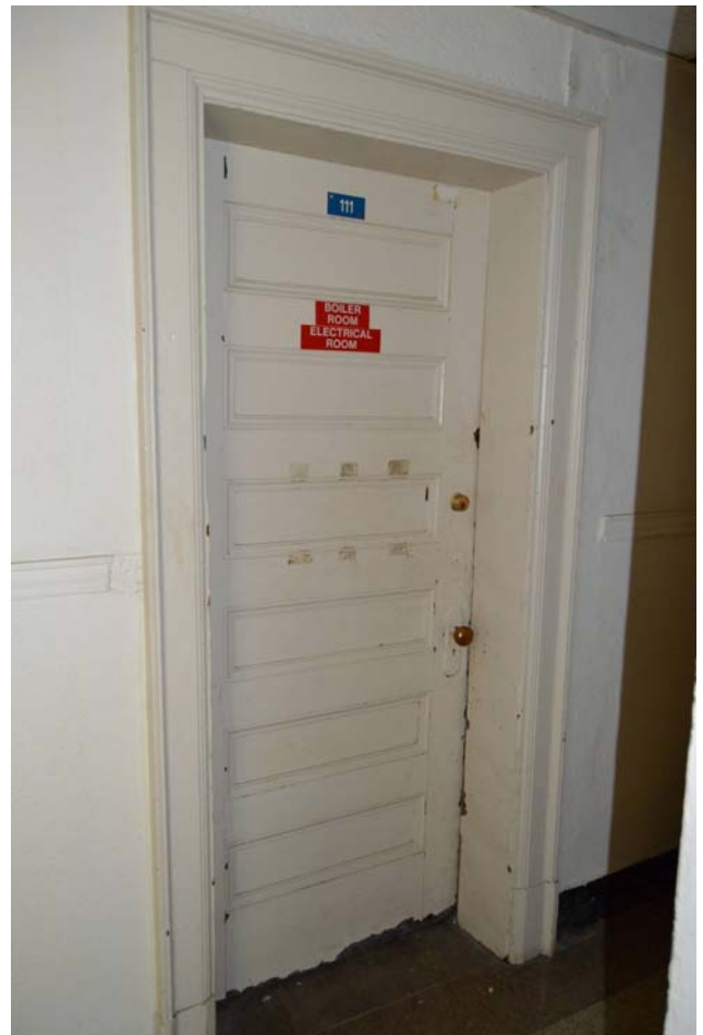
Fig. 120 Room 111 corridor door
