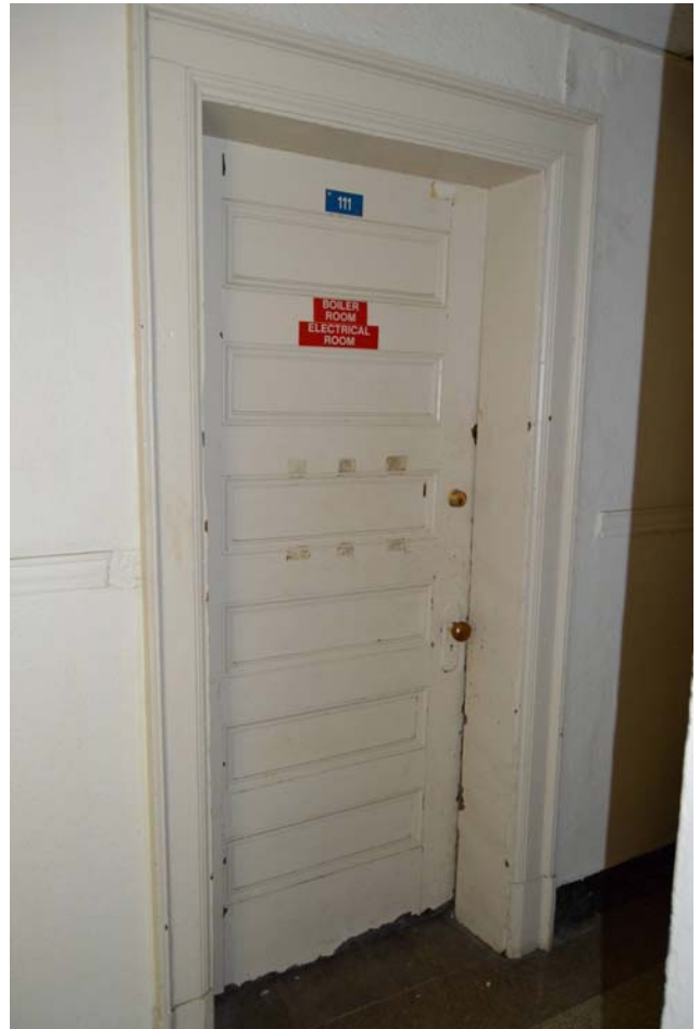
Fig. 120 Room 111 corridor door
