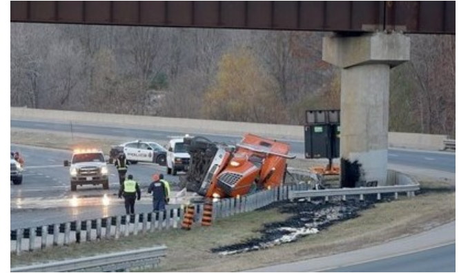
RHVP: Liquid Asphalt Spill
