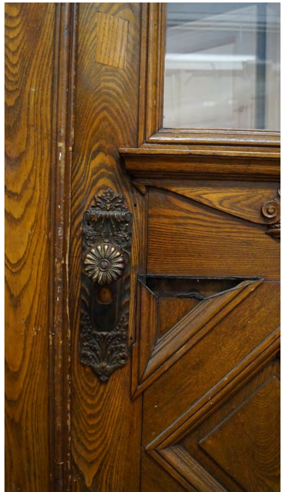
Fig. 163 Ornamental door knob and escutcheon on front door
