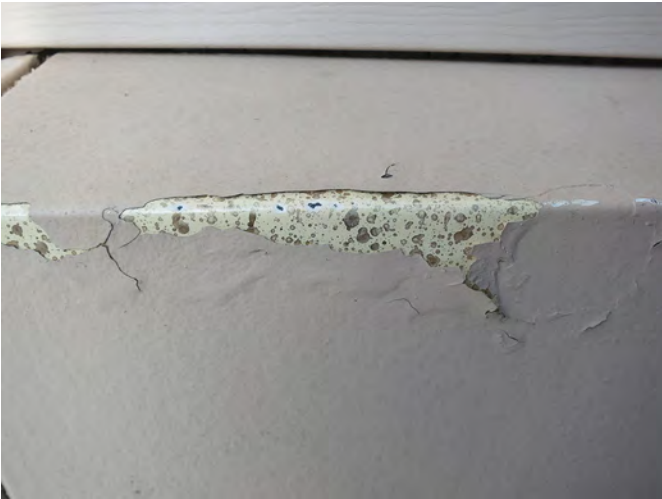
3 Barnesdale Ave. S. - Detail - 10
