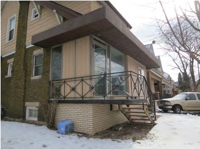
3 Barnesdale Ave. S. - Detail - 04
