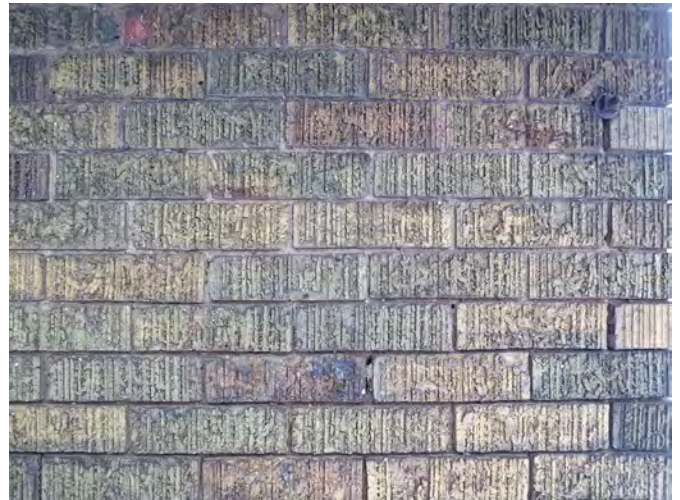
3 Barnesdale Ave. S. - Detail - 01
