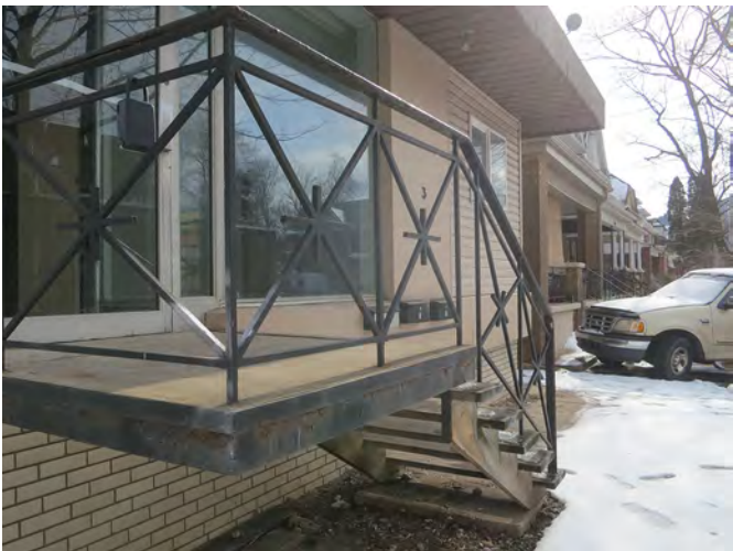
3 Barnesdale Ave. S. - Detail - 06
